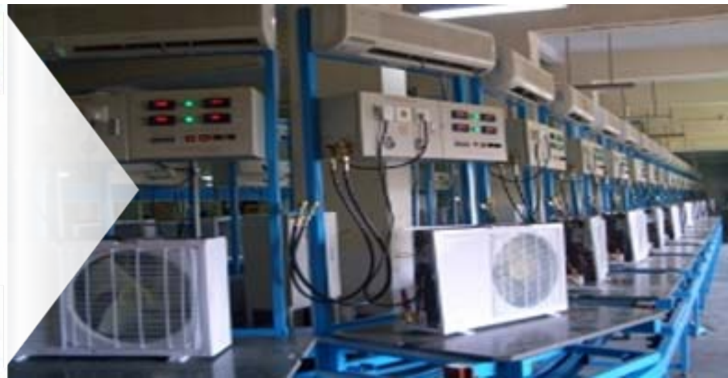
Линия производства кондиционеров на R290
