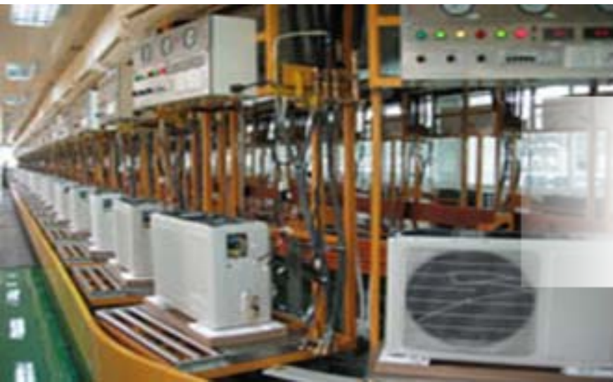
Линия производства кондиционеров на ГХФУ R290
