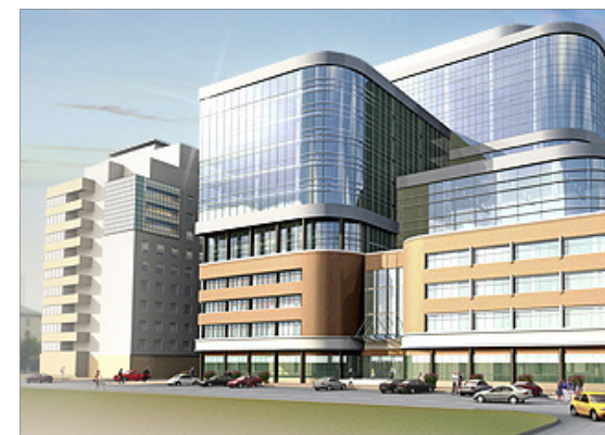
Кондиционирование офисных и жилых зданий
