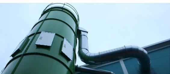
Данная емкость предназначена для предварительного сбора пенополиуретана системой вентиляции для последующей обработки в брикетировочном прессе
