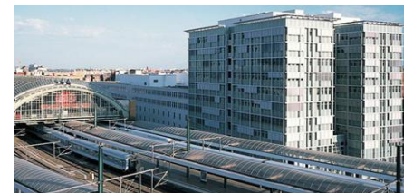
Железнодорожный вокзал, 1 250 кВт
