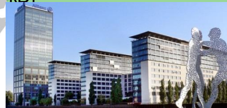
Комплекс административных зданий, 4 220 кВт
