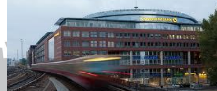
Торговый центр, 1 020 кВт
