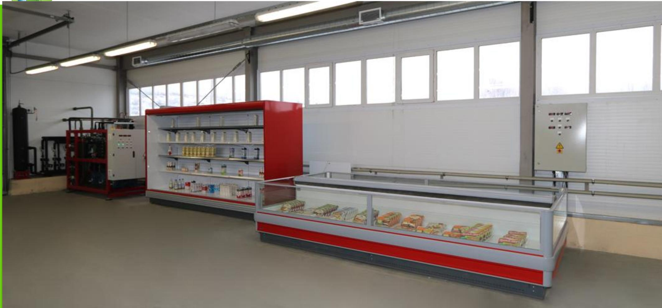
**ДЕЙСТВУЮЩИЙ МАКЕТ ХОЛОДИЛЬНОЙ УСТАНОВКИ НА ДИОКСИДЕ УГЛЕРОДА ДЛЯ МАГАЗИНОВ ПРОДУКТОВОГО РИТЕЙЛА**
