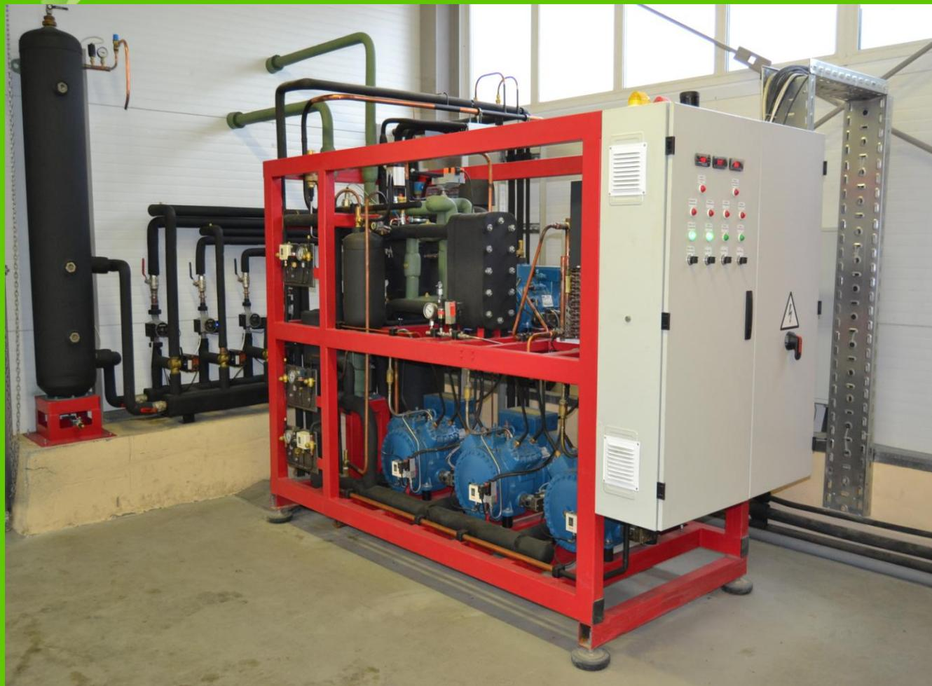
**Данная холодильная установка способна обеспечить магазин площадью до 450 м<sup>2</sup> как средним, так и низким холодом и полностью покрыть потребность в горячей воде.**
